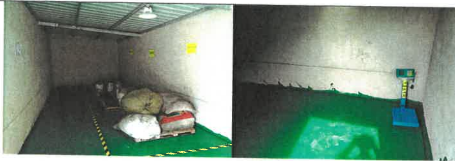
图 3-2 危险废物暂存场所图
