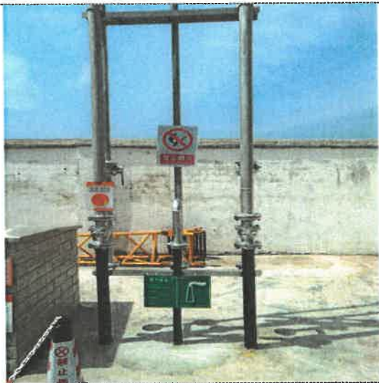
图 3-2 油气回收装置图
