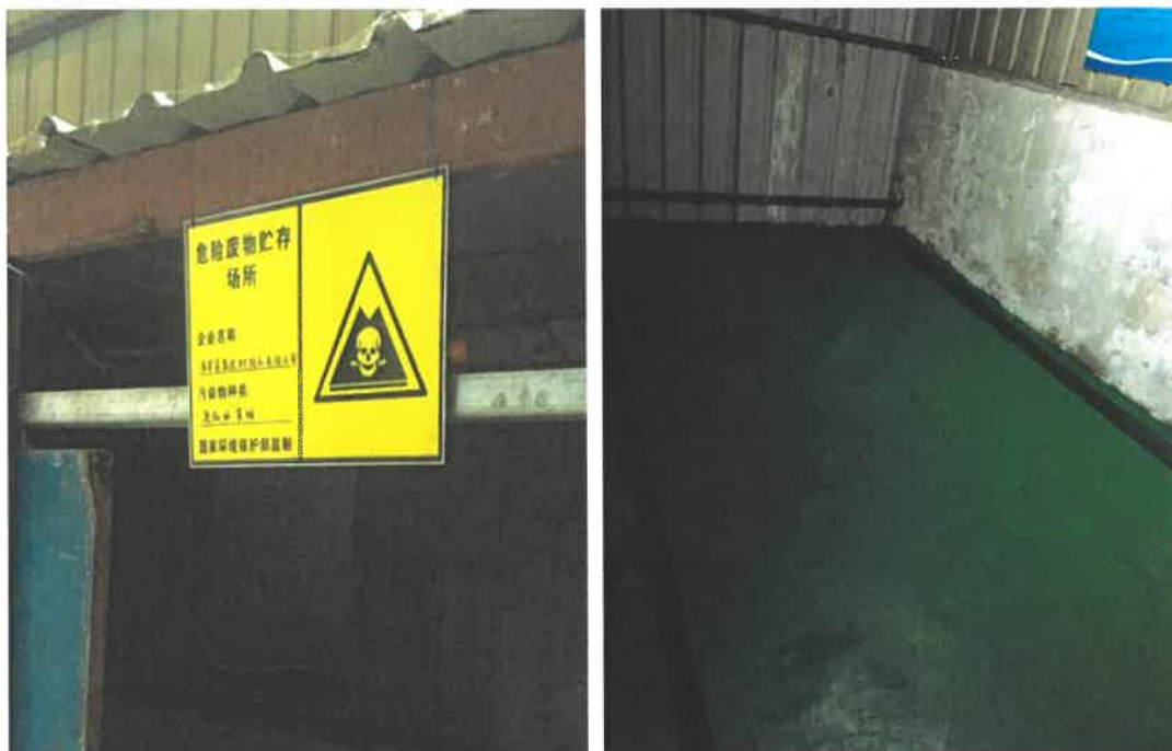
危险废物暂存场所
