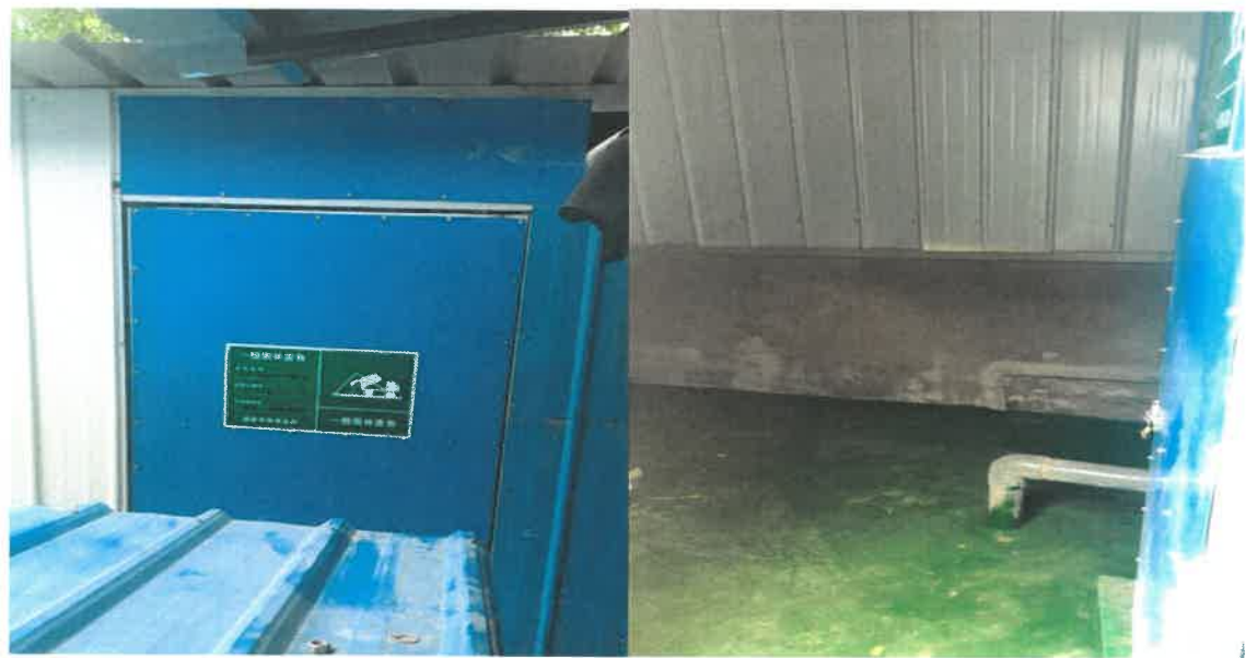
图 3-3 一般固废贮存场所
