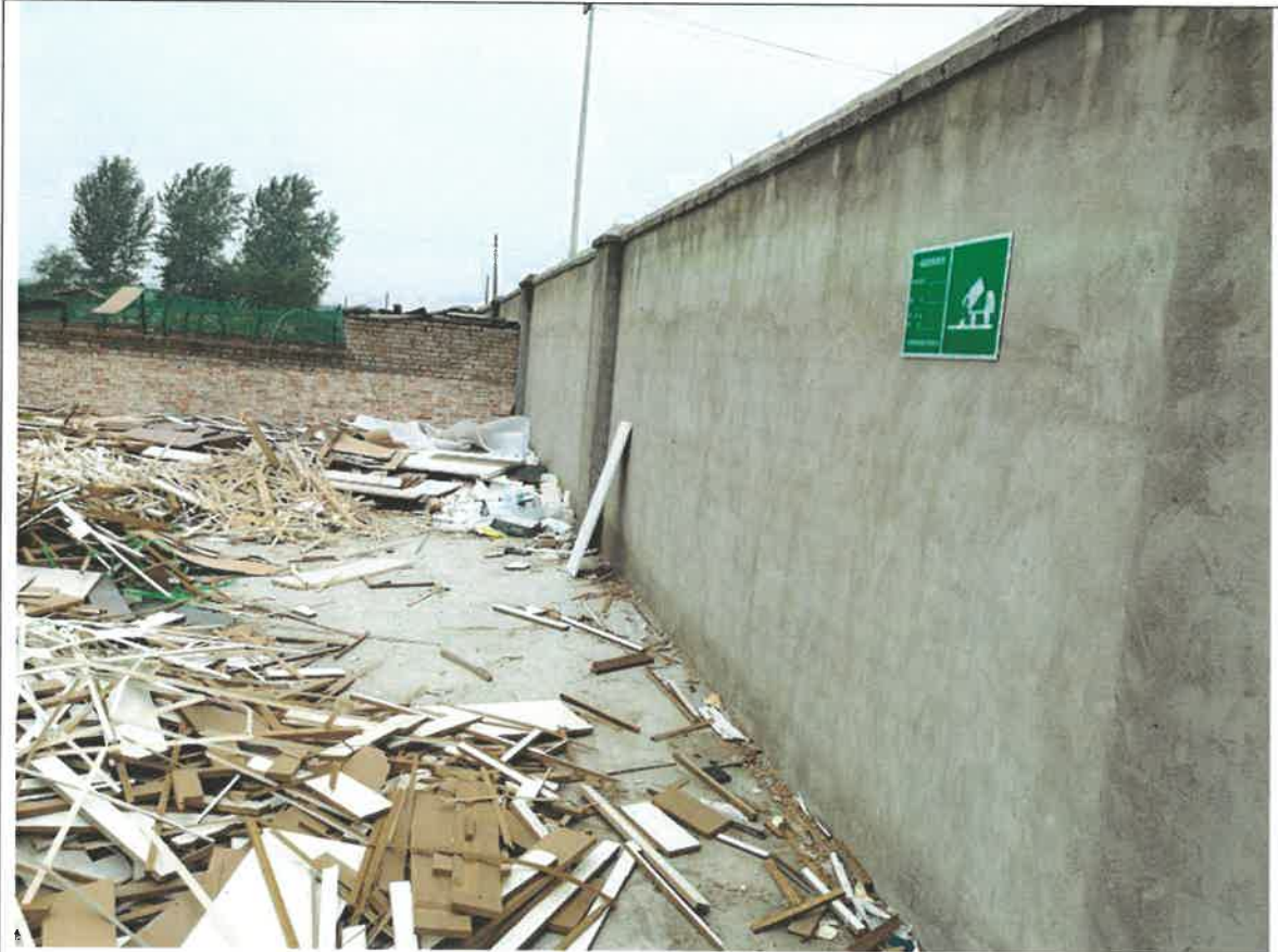
图 3-3 一般固废贮存场所
