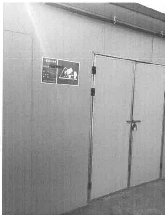
图 4-4-2 一般固废贮存场所照片
