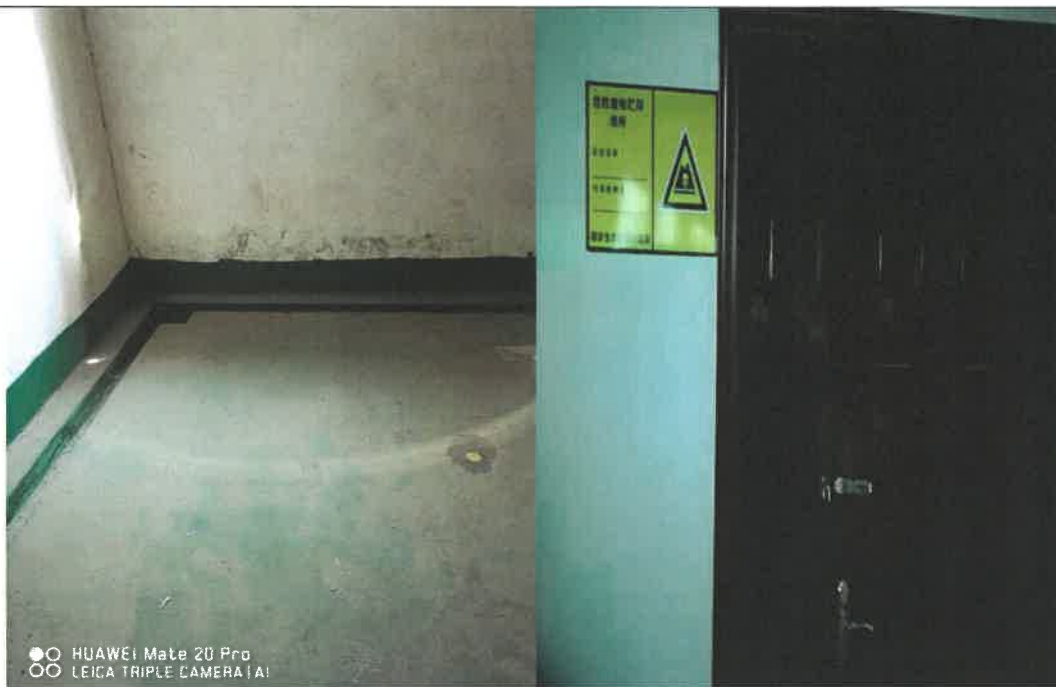
图 3-5-2 危险废物暂存场所
