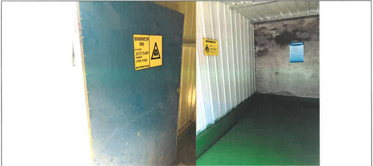
图 3-2 危险废物暂存场所
