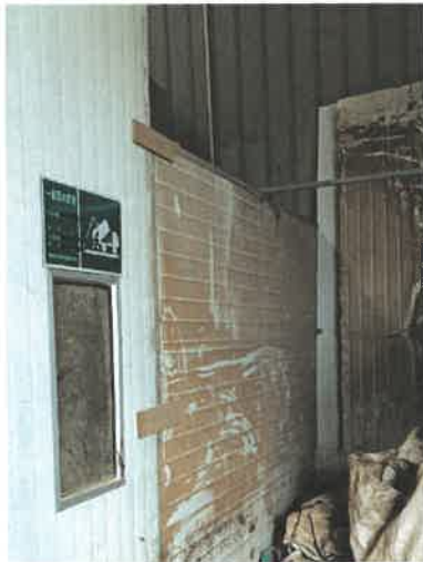
图 3-3 一般固废贮存场所
