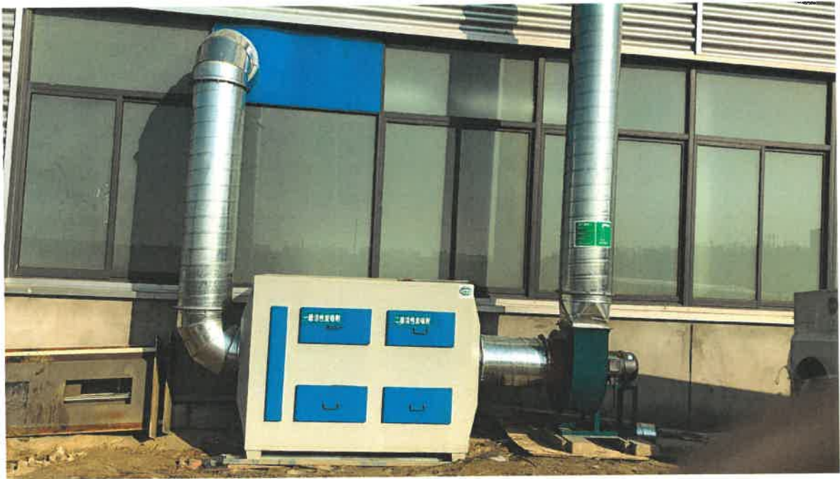
图 3-2 建设项目废气治理措施现状图
