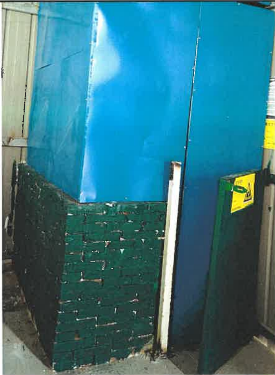
图 3-4 危险废物暂存场所
