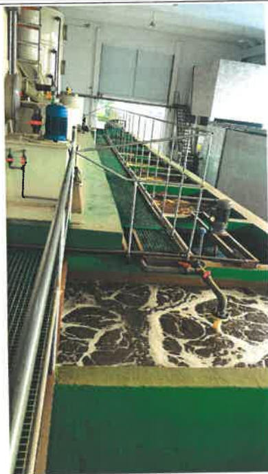
图 3-1 污水处理设施现状图
