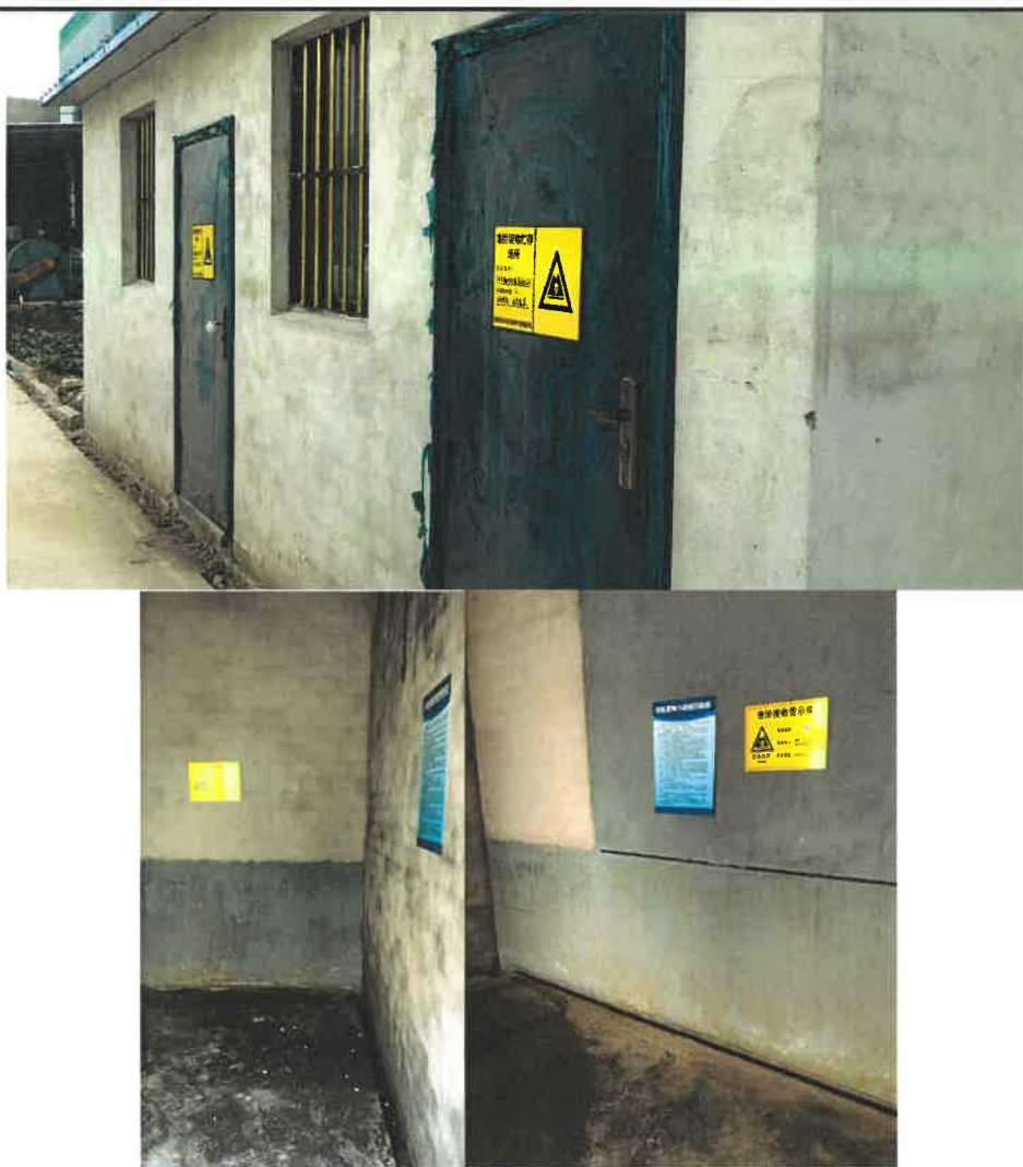
图 3-4 建设项目危险废物暂存场所图
