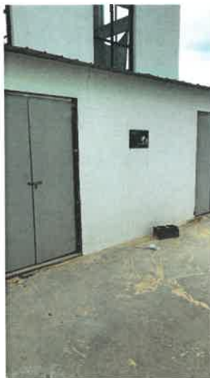
图 3-3 一般固废贮存场所
