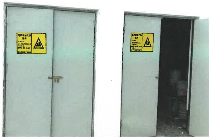
图 3-4 危险废物暂存场所
