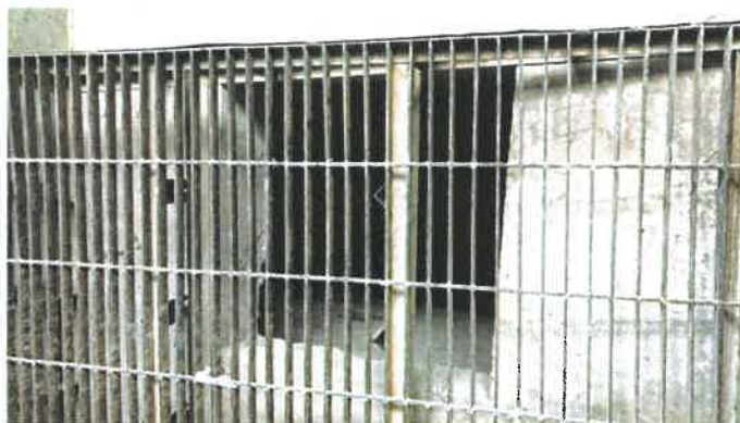
图 3-1 打磨废水三级沉淀池现状图
