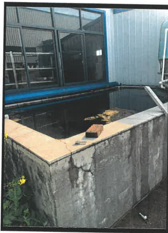
图 3-1 循环冷却水池现状图
