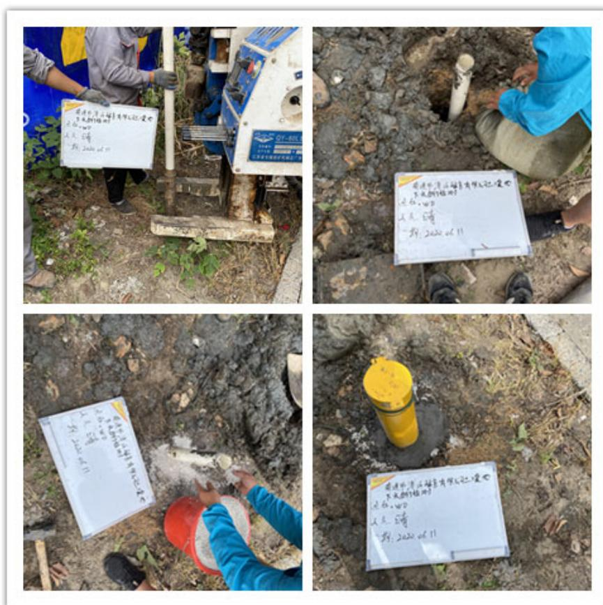
图 5.2-2 W0 建井、下管、填砂及保护措施
