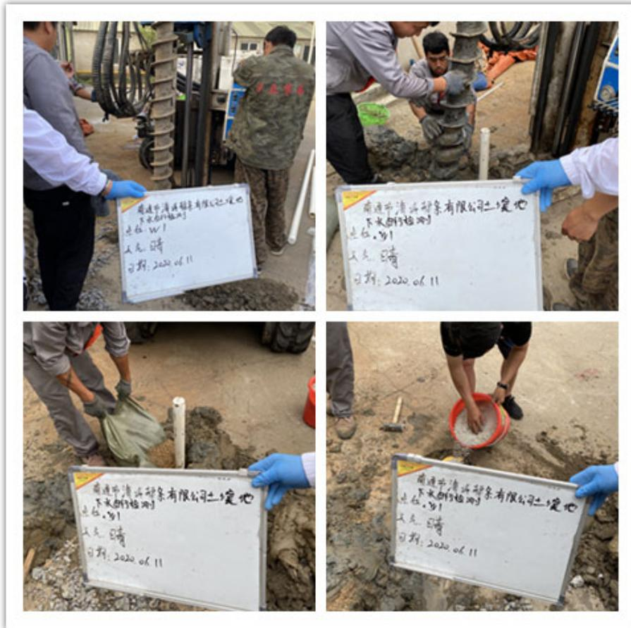
图 5.2-2 W1 建井、下管、填砂、采样
