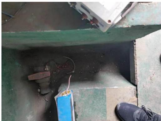
图4-3生产车间（生产车间最低处有阀门，控制漏液）
