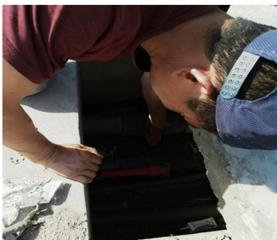
演练切换事故池切换阀
