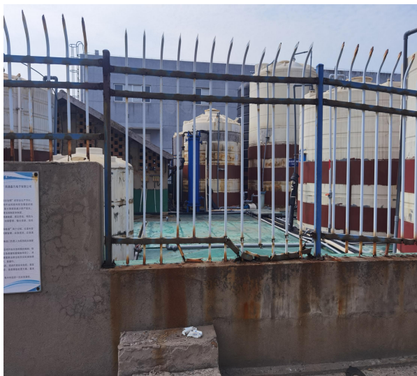
原料酸罐区围堰
