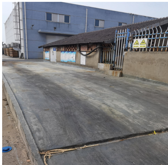
原料酸装卸区围堰
