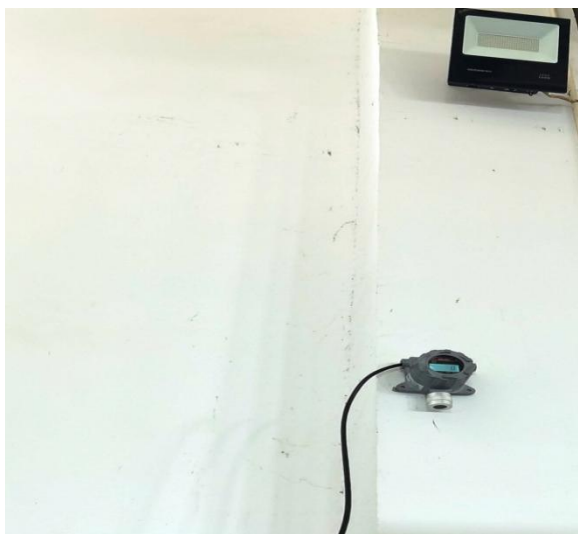
腐蚀车间氢气报警装置
