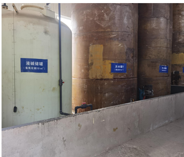
液碱罐区围堰
