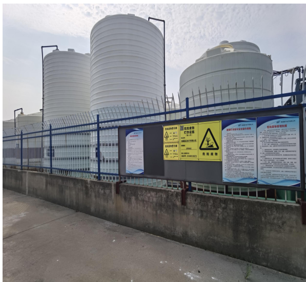
废酸罐区围堰
